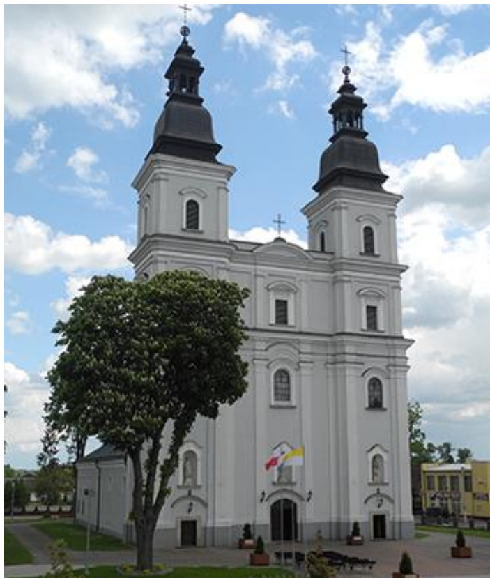
Rycina 4. Kościół Parafialny w Starej Błotnicy nr rej. Nr 30/A/80
